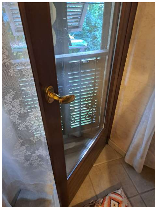
Figura 28 – serramenti al piano primo
